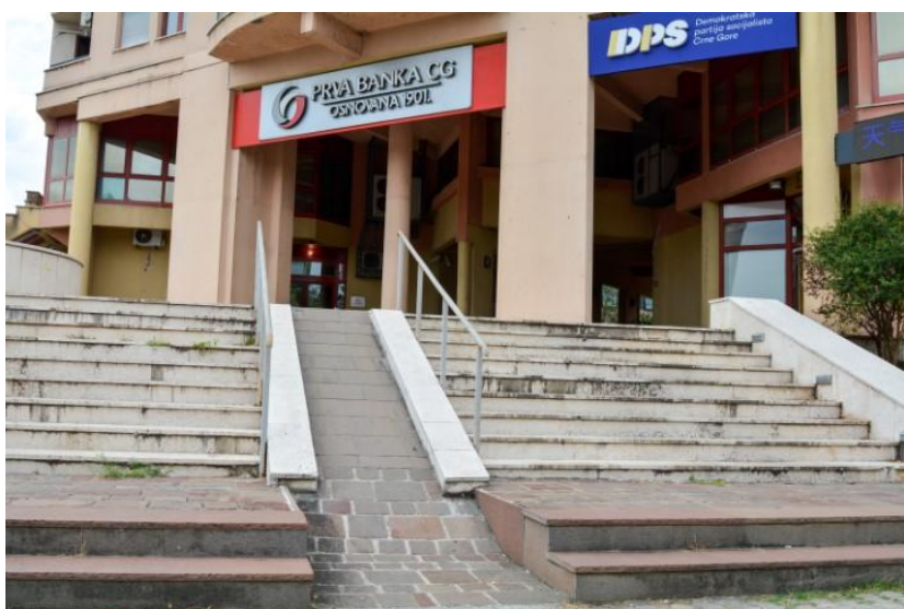
Rampe kod zgrade „Vektre“
